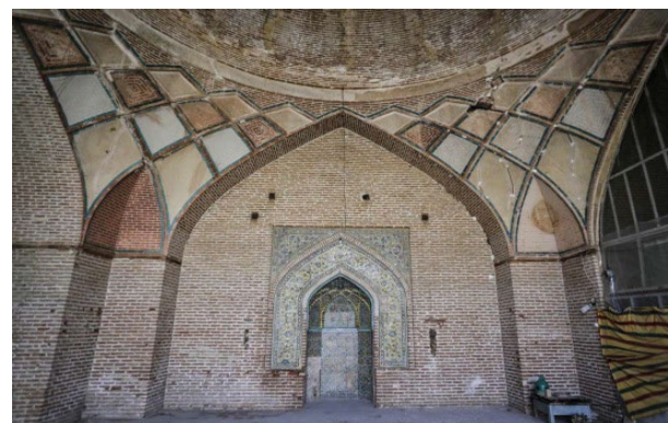
شکل ۴: فضای زیر گنبد میانی، تاق میانی آجری سقف شبستان که از دو تاق دیگر بزرگتر است [۲۹]
