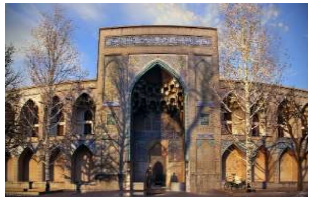
تصویر ۱۲: نمای جلویی مدرسه چهارباغ [۲۰] Fig. 12: Chaharbagh school frontal view [20]
