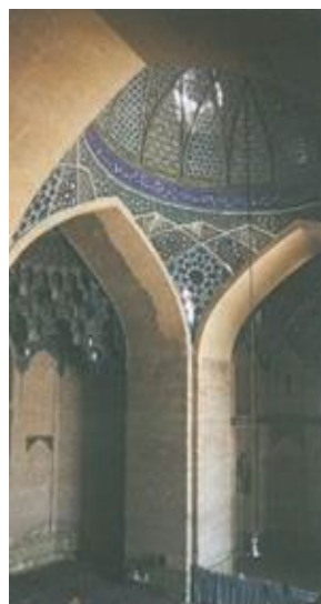
شکل ۷: بخشی از گنبدخانه [۳۲] Fig. 7: A section of dome chamber [32]
