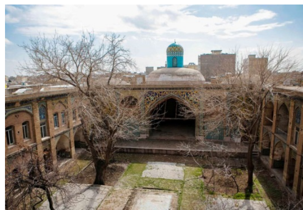
شکل ۳: حیاط و جبهه جنوبی، در ضلع جنوبی مهتابی وجود دارد که به اندازه یک متر از سطح حیاط بالاتر است و شبستان مسجد نیز در این جبهه قرار گرفته است [۲۹]
